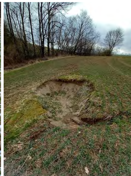
Obrázek č. 67: Kaverna vzniklá v souvislosti s nefunkční a poškozenou (propadlou) drenáží, vlevo leden 2022, vpravo únor 2022
