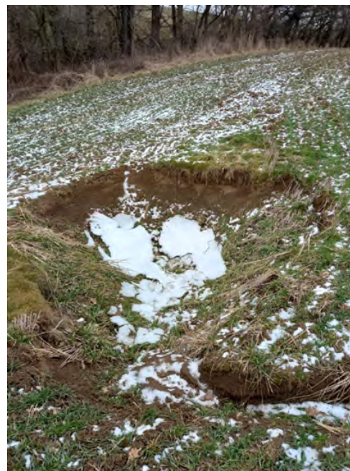
Obrázek č. 67: Kaverna vzniklá v souvislosti s nefunkční a poškozenou (propadlou) drenáží, vlevo leden 2022, vpravo únor 2022
