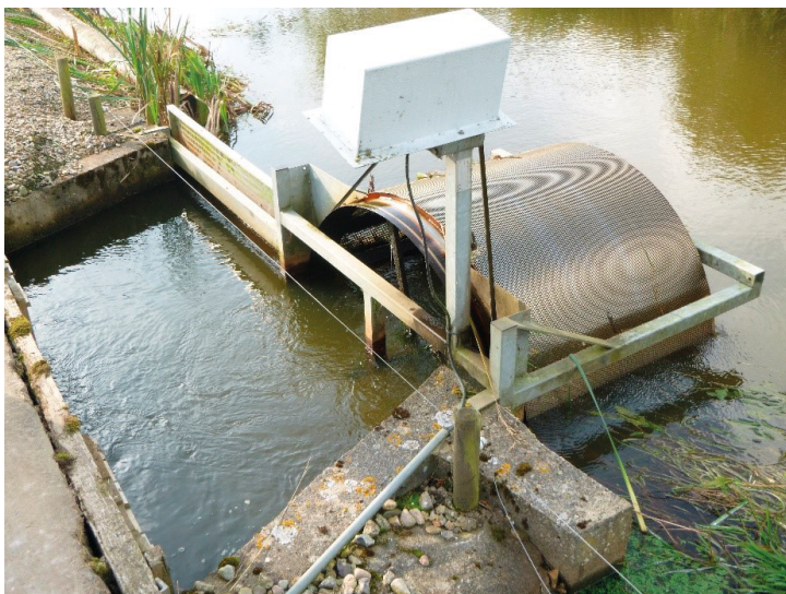
Obr. 3: Jedna z možností umístění mechanické filtrace na přítoku z malé říčky do chovného systému.
