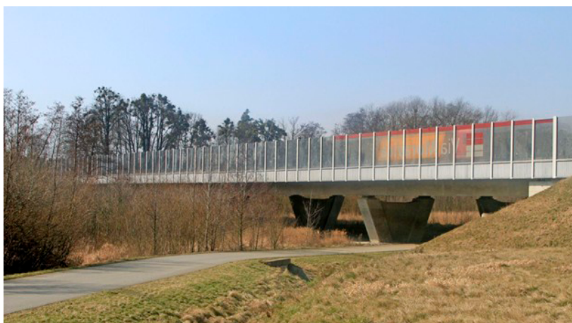
1: Multifunkční podchod u Klimkovic zajišťuje křížení dálnice D1 s účelovou komunikací, vodním tokem i vytváří migrační prostor pro živočichy
