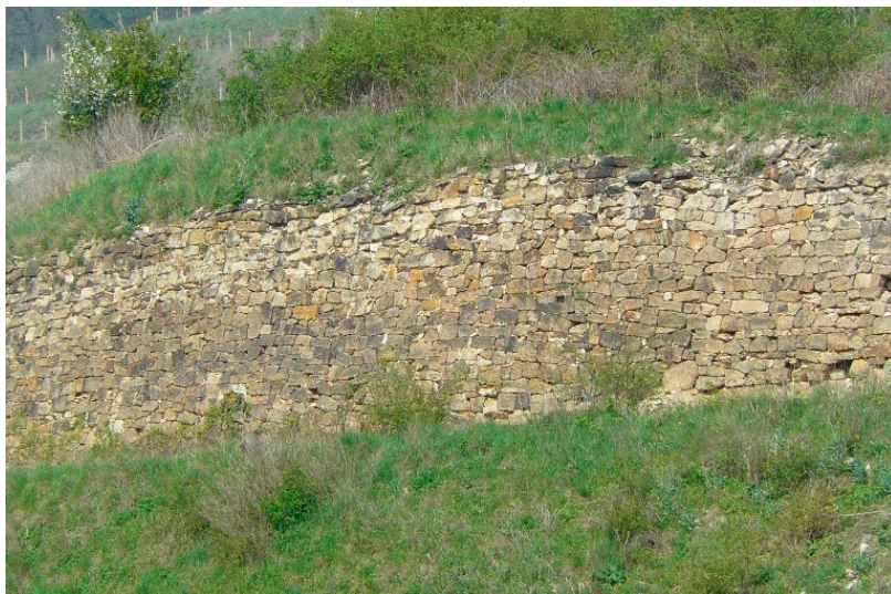
5: Opěrná zeď na vinici Malá Vendule ve Velkých Žernosekách z opuky, která přečkala terasování v polovině 80. let 20. století
