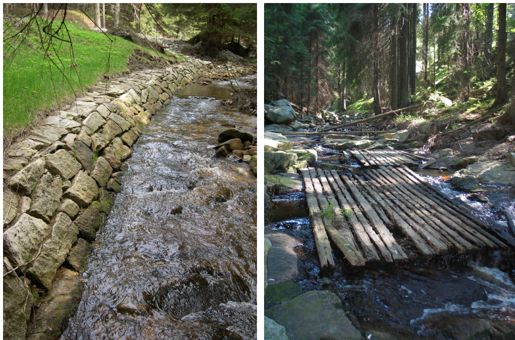
2: Opevnění ohbí řeky Černé pod Zlatou Ktiší a výdřeva koryta Pohořského potoka. Oba snímky pocházejí z roku 2003 a zachycují tak stav nedlouho po povodni v roce 2002.
